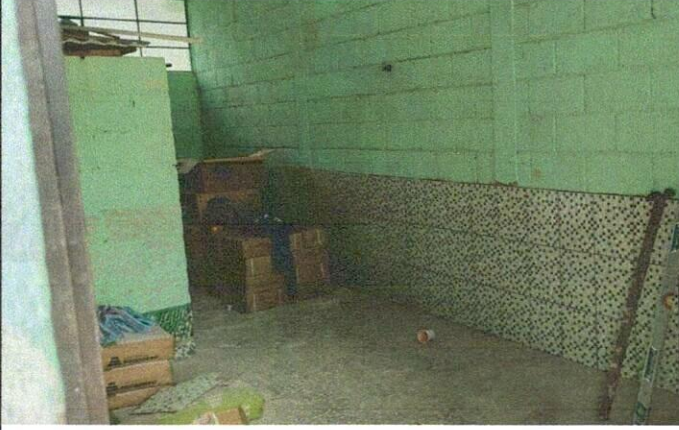
Foto1: Reparación de servicios sanitarios.
